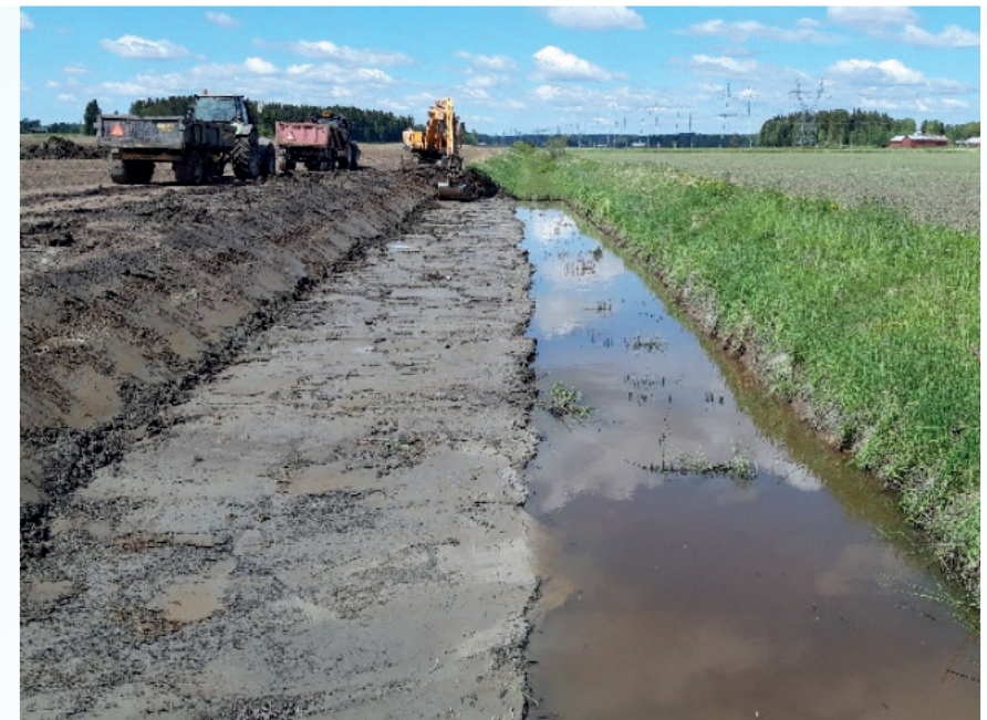
To-trins grøfteprincip (foto: Heidi Nurminen) og udgravning af flodsletter (foto: Kaisa Västilä).
