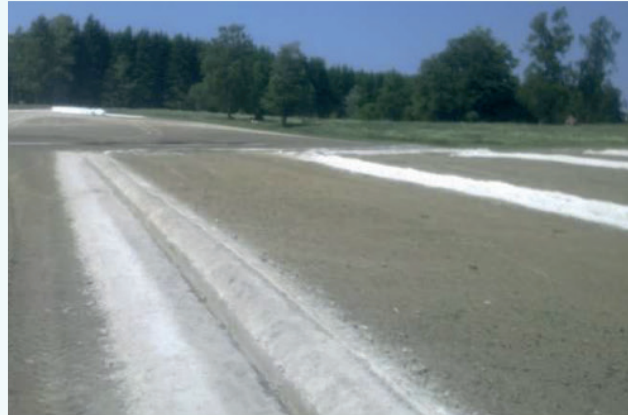
Suodatusojat (kalkki ja biohiili) & rakennekalkitus
