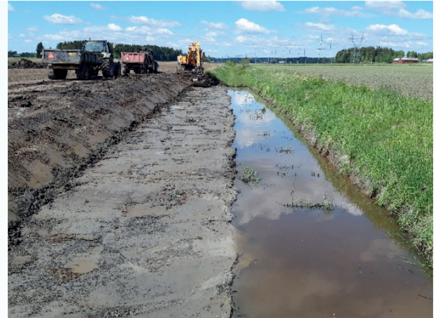
Kaksivaiheinen ojan periaate (kuva: Heidi Nurminen) ja tulvan louhintatyöt (kuva: Kaisa Västilä).
