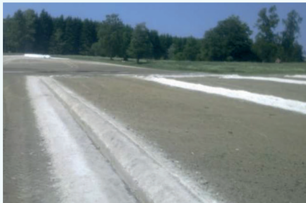
Filtravimo grioviai (kalkės ir bioanglys) ir konstrukcijų kalkinimas
