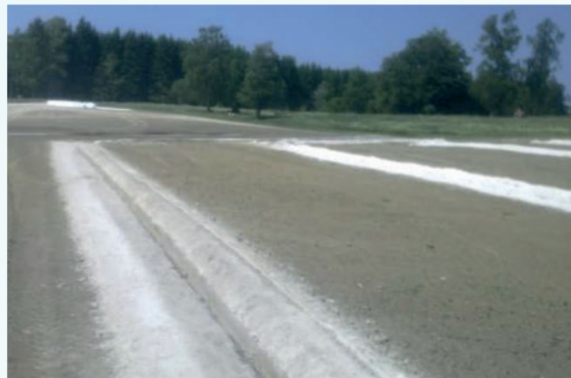
Filtrgrāvji (kaļķi un bioogle) un konstrukciju kaļķošana
