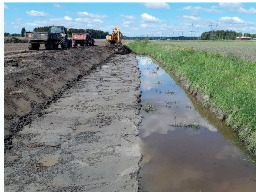
Divpakāpju grāvja princips (foto: Heidi Nurminen) un palienes rakšanas darbi (foto: Kaisa Västilä).
