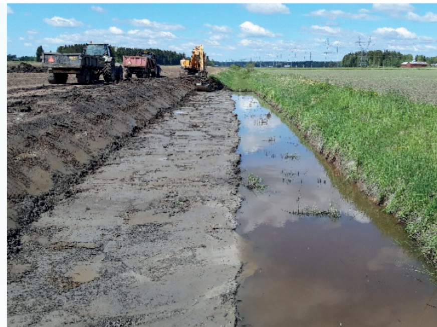
Zasada dwuetapowego rowu (fot. Heidi Nurminen) i prace wykopaliskowe na terenach zalewowych (fot. Kaisa Västilä)
